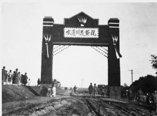
大正 13 (1924) 年 10 月 12 日に行われた新荒川通水式の様子。
